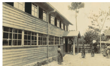
1909(明治42)年頃の木造校舎
